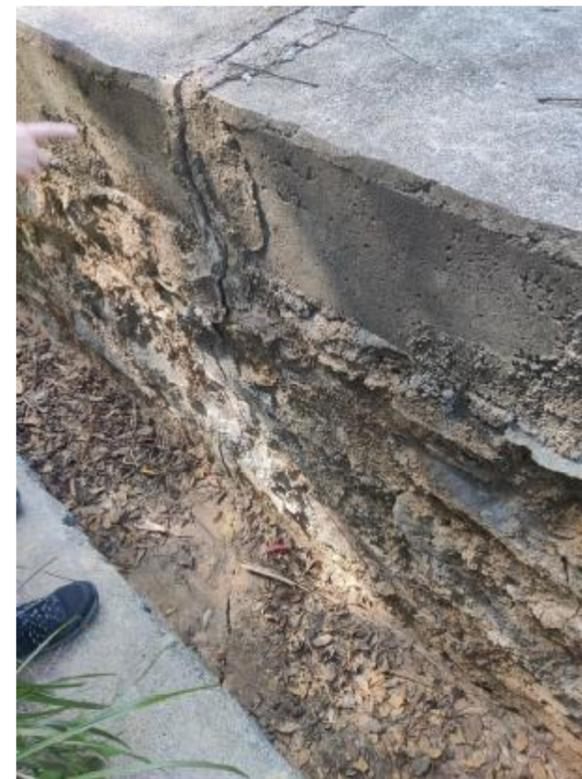
图 2. 墙顶及排水沟开裂
