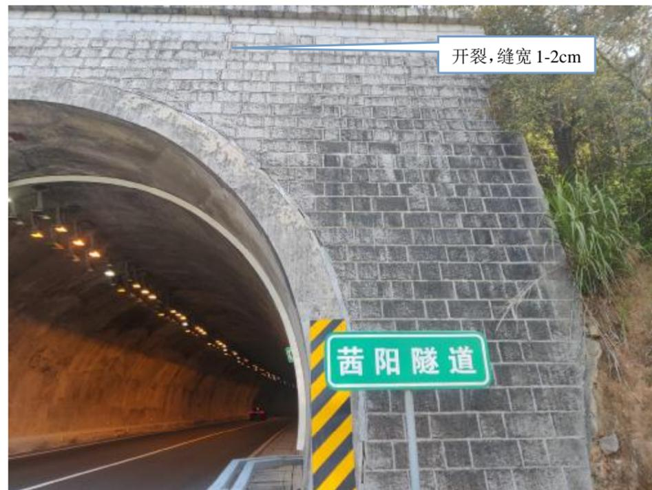
图 1 洞门墙墙顶竖向裂缝
